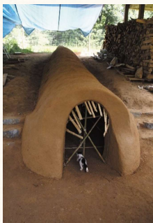
アーチの骨組みに土をのせて大地の分身「土窯」の完成 Pack soil on the arching frame to complete the "Tsuchigama (Earthen kiln)".
